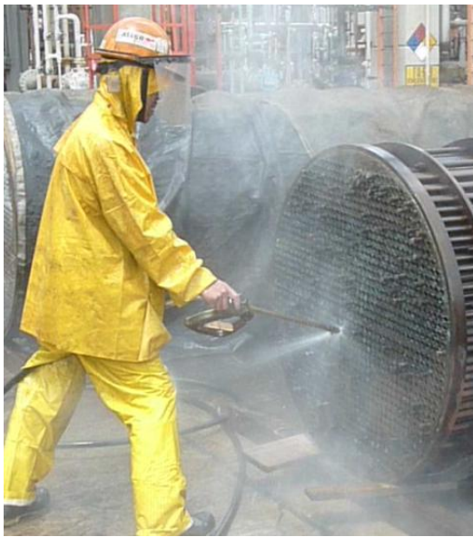
Fig. 2: Limpieza manual por chorro de agua a presión – fase principal.
